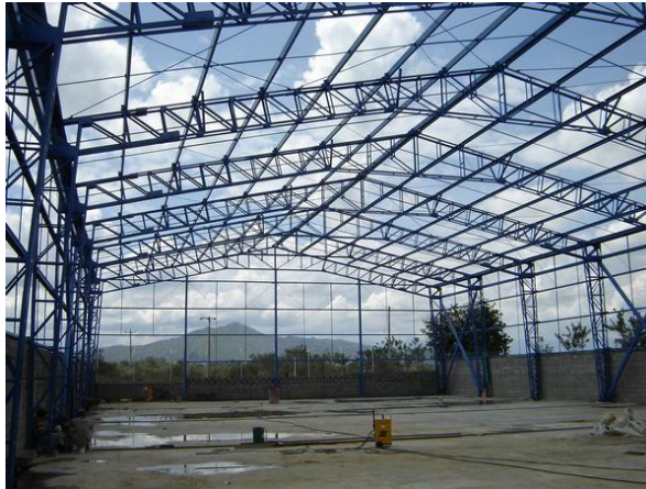
Figura 13. Estructura de Bodega
